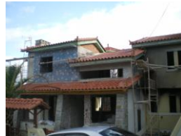
Επισκευή πυρόπληκτης οικίας (Άγιος Στέφανος Αττικής)
