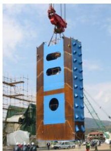
Γέφυρα Ρίου Αντιρρίου Ανέγερση κεφαλής πυλώνα
