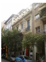
Επισκευή Νεοκλασικού κτιρίου (Αθήνα)
